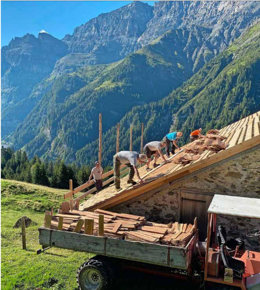
Teamarbeit der Schindelleger: Schindelreihe um Schindelreihe wird anhand des Richtbretts bündig genagelt.
