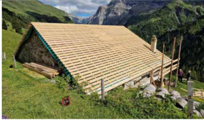
Bereit: Das Dach der vorderen Hütte kann während der nächsten Wochen mit Lärchenschindeln gedeckt werden. Bild Efraim Utzinger
